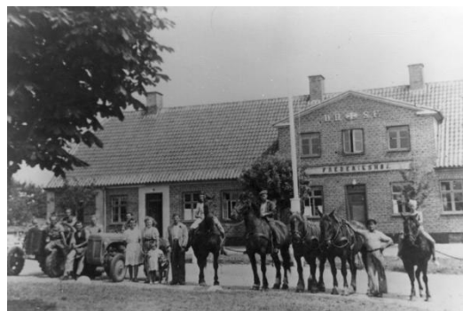
Frederikshøj ved en senere lejlighed.
